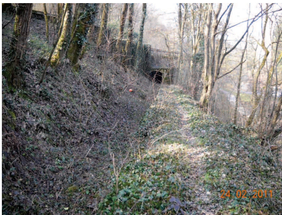
Foto 1: Resti del vecchio tracciato della Roggia Principe (sullo sfondo si osserva l’inizio del tratto coperto che scorreva al di sotto della linea ferroviaria).
